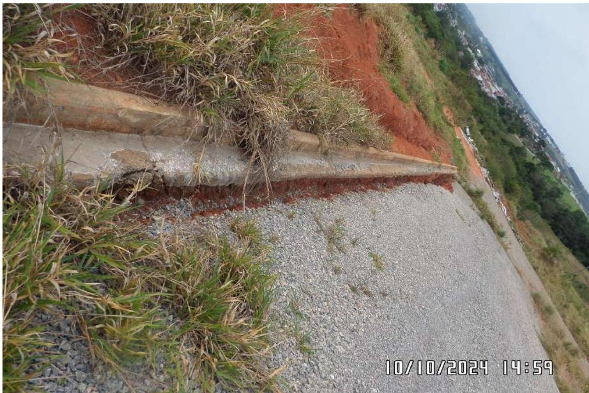
**IMAGEM 14** – Na imagem é possível observar pela Rua 10 que devido ao lapso temporal em que a obra se encontra paralisada, as chuvas criaram caminhos na parte mais baixa do leito carroçável em função da topografia transversal e percorreram para o trecho mais baixo devido a topografia longitudinal, carreando parte do solo e danificando o serviço de pavimentação.
