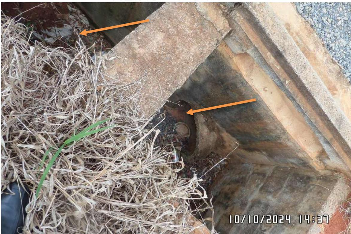
**IMAGEM 4** - Na seta laranja, pode-se observar ao lado oposto ainda na Rua 12 que a caixa de captação pluvial está com sujeira por dentro e em volta, bem como não possui o acabamento com tampa e acabamento interior.
