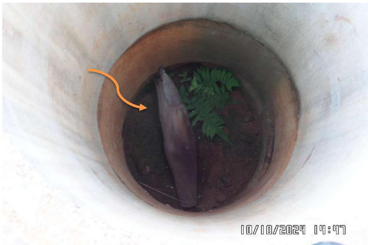
**IMAGEM 8** – Na imagem possível observar que o PV, encontra-se entupido no trecho da Rua 12 próximo à curva.
