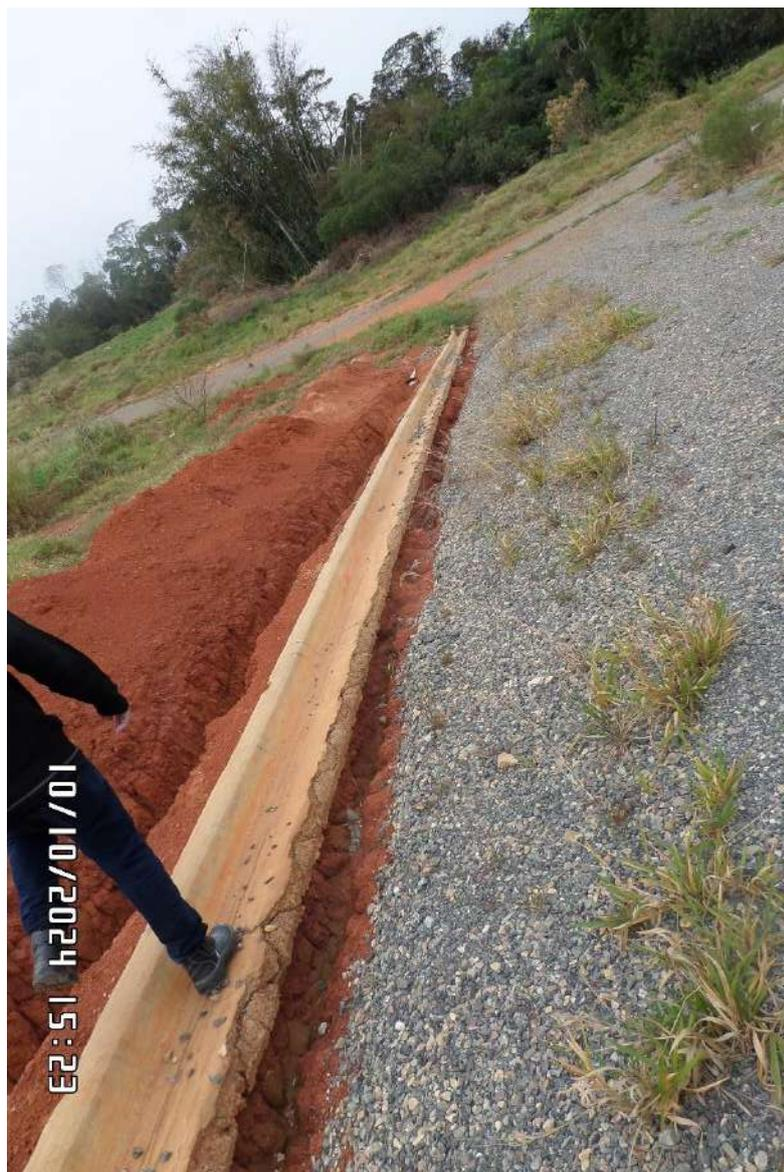
**IMAGEM 18** – Na imagem é possível observar que o pavimento neste trecho está gravemente danificado pelo assoreamento sofrido ao longo dos anos.
