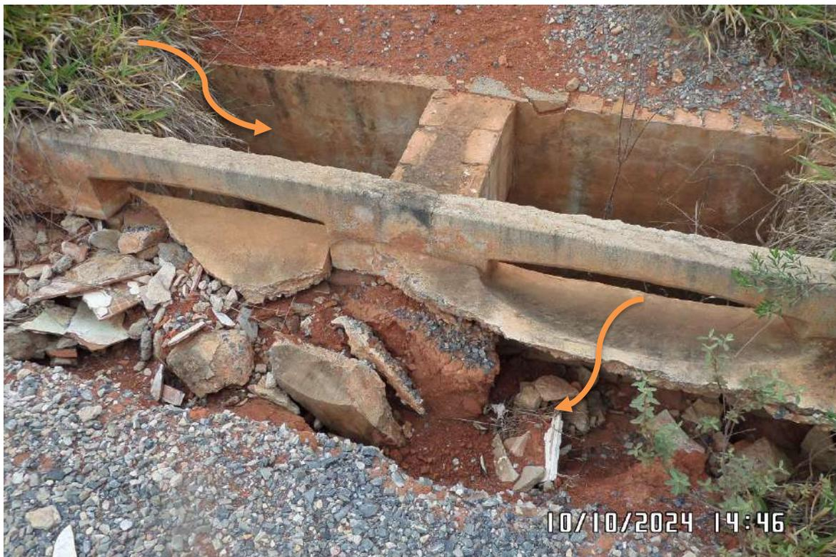
**IMAGEM 5** – Na imagem é possível observar que a caixa de captação pluvial se encontra gravemente danificada, com sinais de assoreamento em seu entorno.
