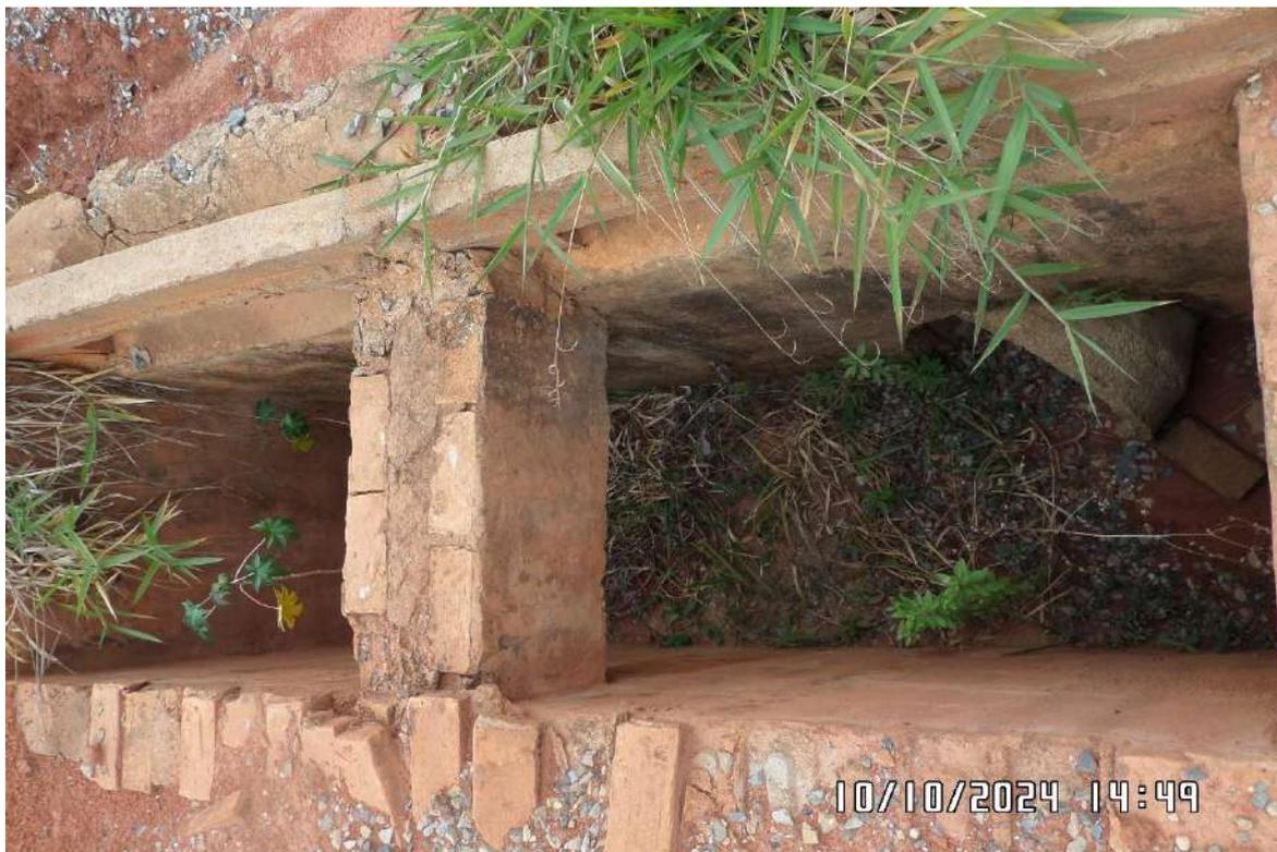
**IMAGEM 9** – Na imagem é possível observar condições similares às caixas vistoriadas anteriormente, estando esta danificada com necessidade de limpeza, sem tampas e acabamentos.
