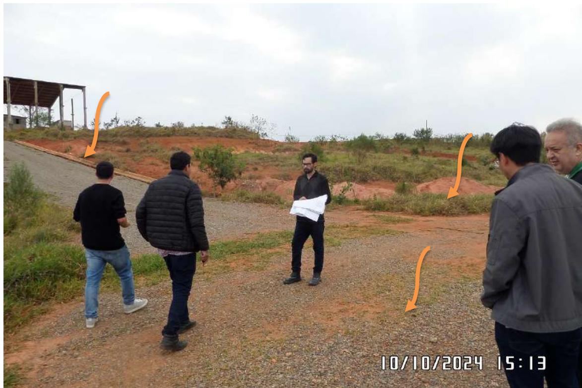
**IMAGEM 17** – Na imagem é possível observar no cruzamento da Rua 7 com a Rua 16 as mesmas condições da pavimentação das imagens anteriores, bem como sinais de assoreamento no canto da Rua 7, parte baixa do leito carroçável.
