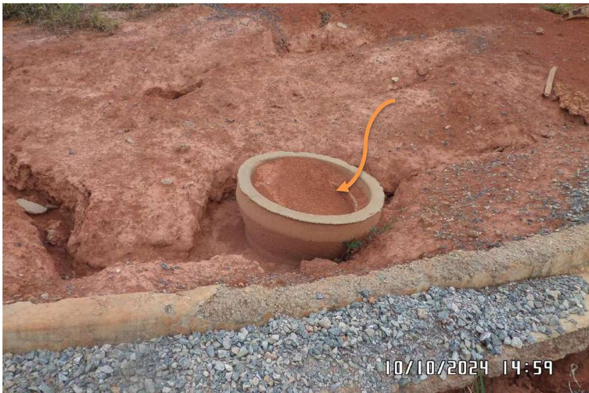
**IMAGEM 15** – Na imagem é possível observar outro PV obstruído, bem como o solapamento do solo em função das águas pluviais que percorrem o caminho natural em razão da topografia e gravidade.
