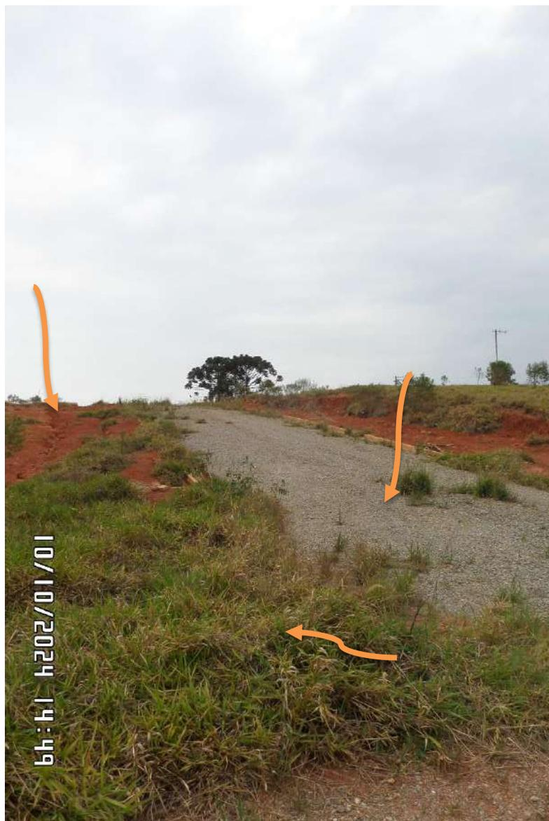
**IMAGEM 9** – Na imagem é possível observar a Rua 11 onde tem-se as condições de pavimentação iguais as fotos anteriores, com sinais de avanço de mato, e sinais de erosão no entorno.
