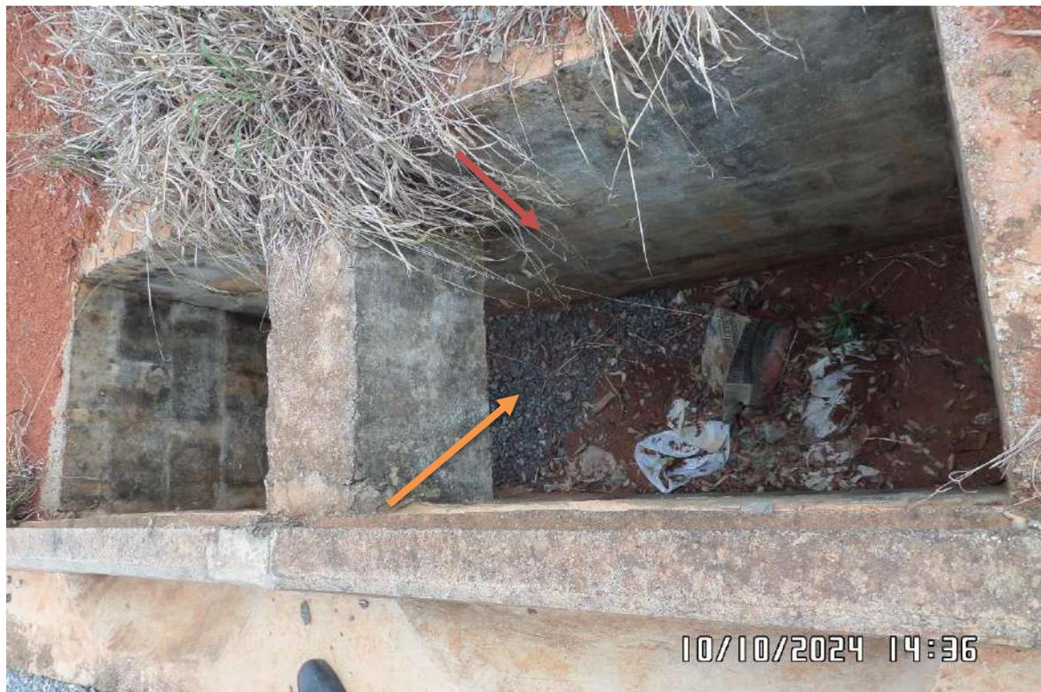
**IMAGEM 3** - Na seta laranja, pode-se observar que a caixa de captação pluvial está com sujeira por dentro e em volta, bem como não possui o acabamento com tampa.
