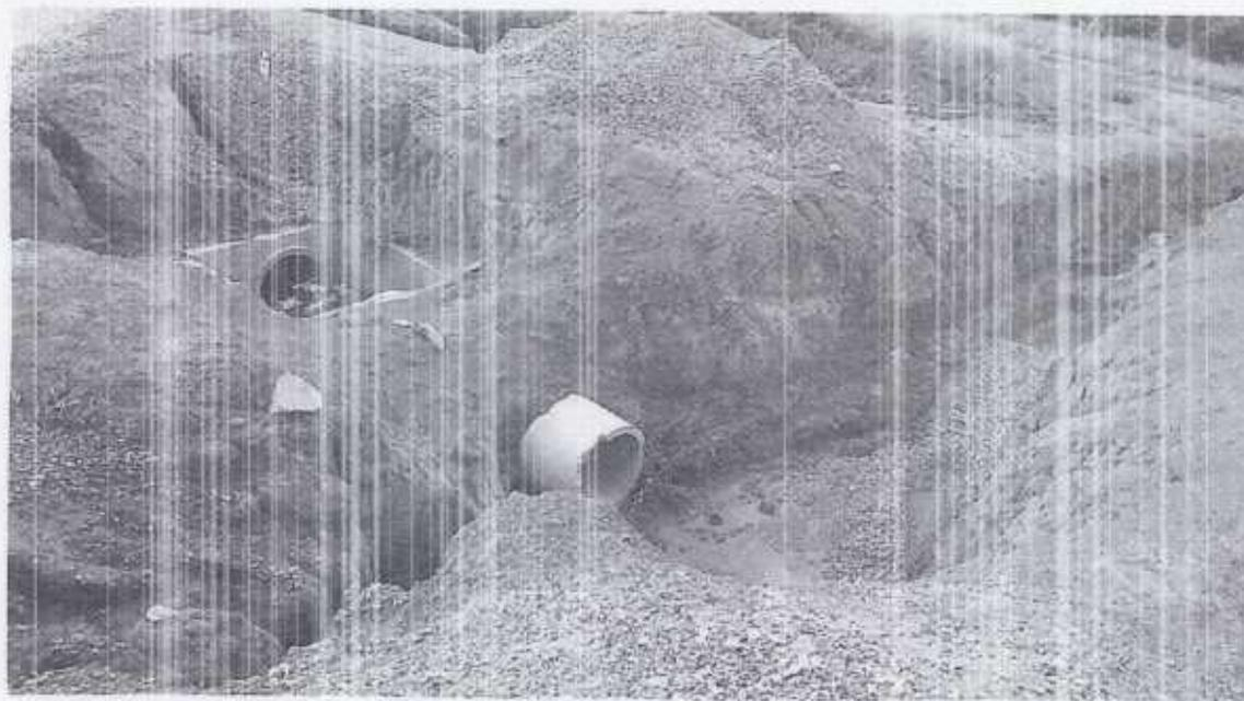
**Imagem 39** – Rua 10 – Trecho sem demarcação da via, sem execução das guias e pavimento, tubulação exposta.
