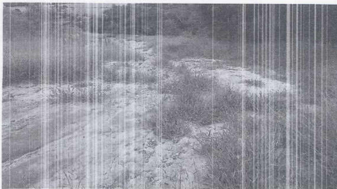
Imagem 11 - Rua 04 - Sem demarcação da via, sem execução das guias e pavimento.
