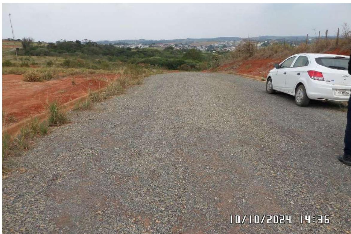
**IMAGEM 2** – Vista da Rua 12 próximo à Avenida, onde pode-se observar que esta possui sub-base e base parcialmente executadas, entretanto expostas a condições climáticas por alguns anos, precisarão passar por processos de recomposição para garantia de qualidade e durabilidade.
