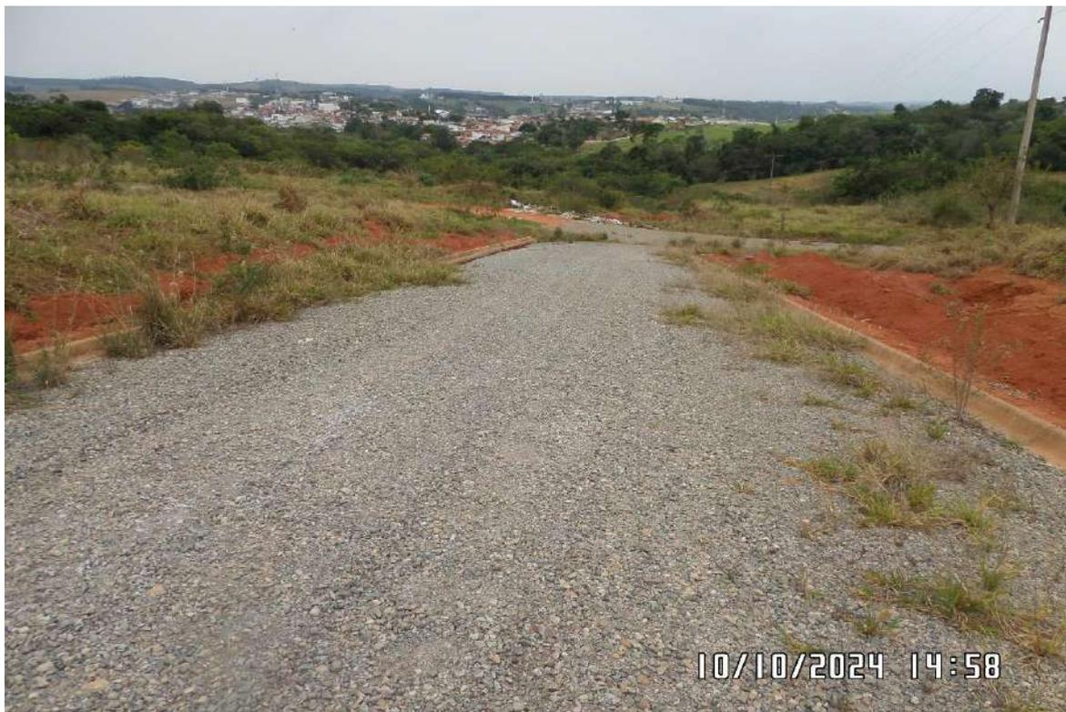
**IMAGEM 13** – Na imagem é possível observar pela Rua 10 a condições semelhantes de pavimentação e de vegetações sobre a rua, existem alguns trechos com sinais de assoreamento.
