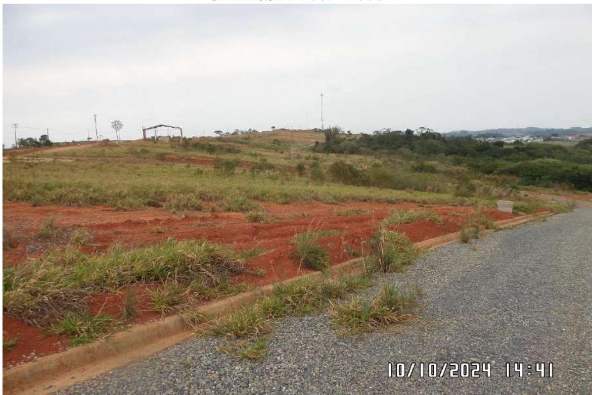
**IMAGEM 4** – Na imagem é possível observar o loteamento de forma mais ampla onde pode-se constatar um PV de Esgoto abaixo e colocação de guias nas laterais. Pode-se observar que não existe executada a parte de Rede Elétrica e Iluminação Pública.
