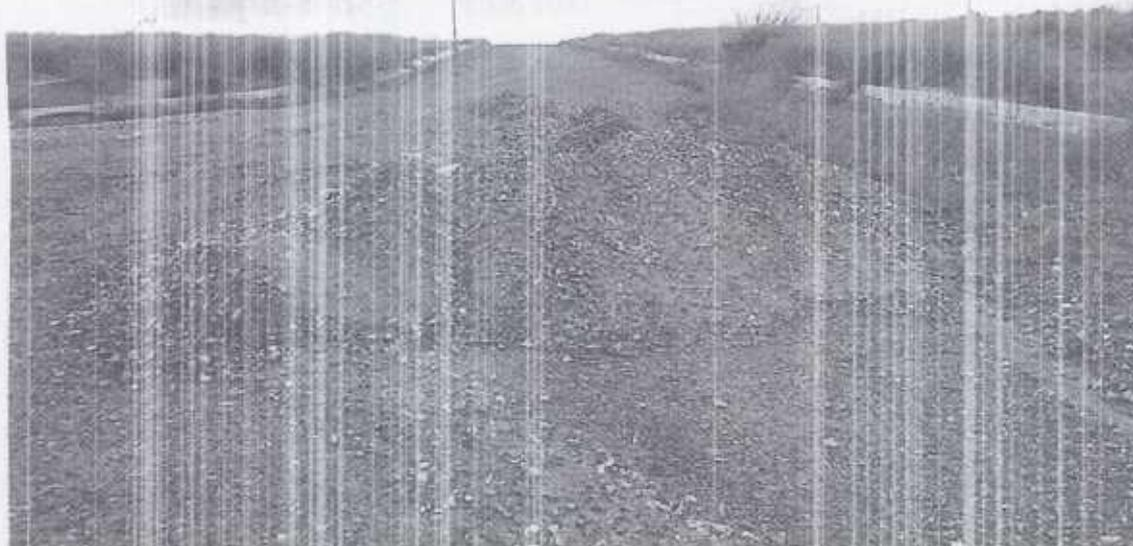
**Imagem 05** – Rua 03 – Base do pavimento executada, em estado deteriorado.
