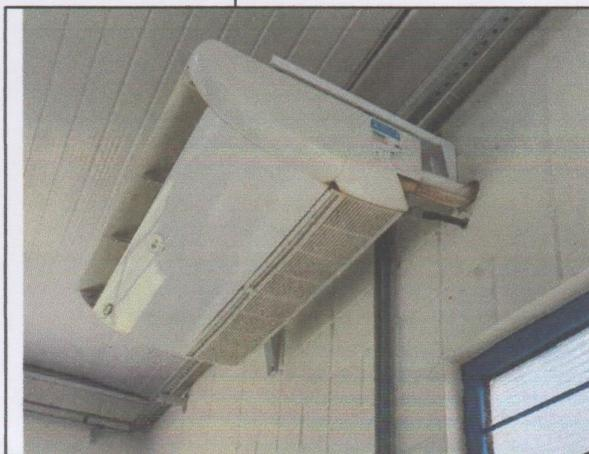
Foto 3: Ar Condicionado Tipo Split ( Apenas Ventilação )
