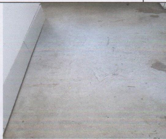
Foto 4: Piso Concreto ( falta nível e revestimento )
