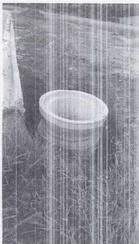
Imagem 28, 29, 30 e 31 – Rua 08 – Caixas de captação de águas pluviais, tubulações expostas e deterioradas. 23 de maio de 2.022.
