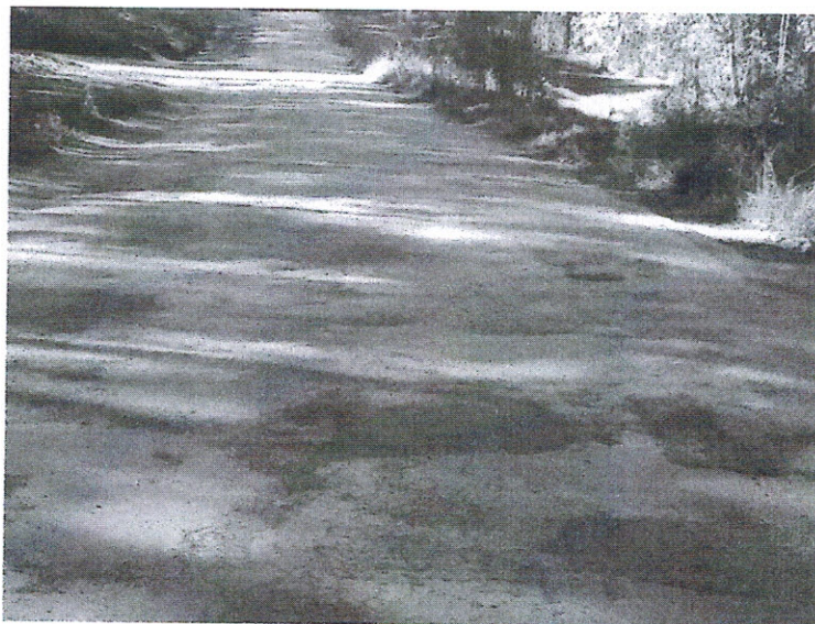
Imagem 02 - Manutenção de tapa buracos
