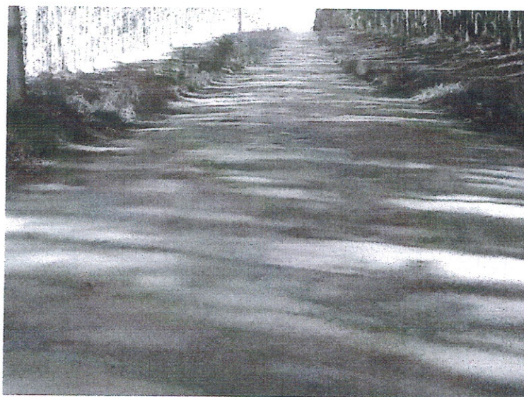
Imagem 03' - Manutenção de tapa buracos
